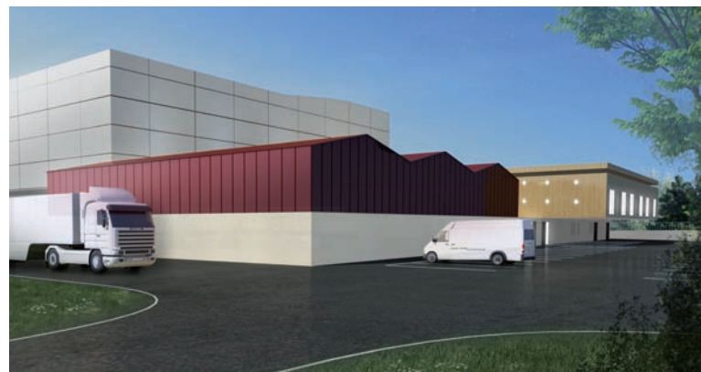
UNE VUE DES ESPACES TECHNIQUES
