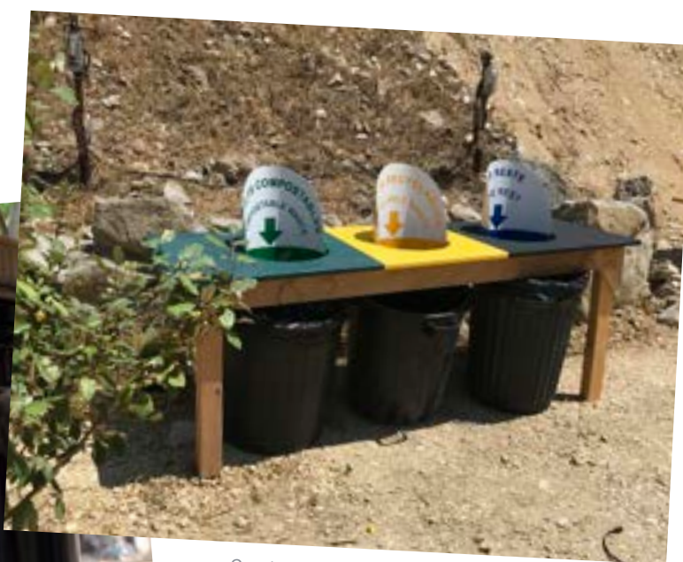
Construction de poubelles à la Carrière de Boulbon, 2025 © Festival d'Avignon
